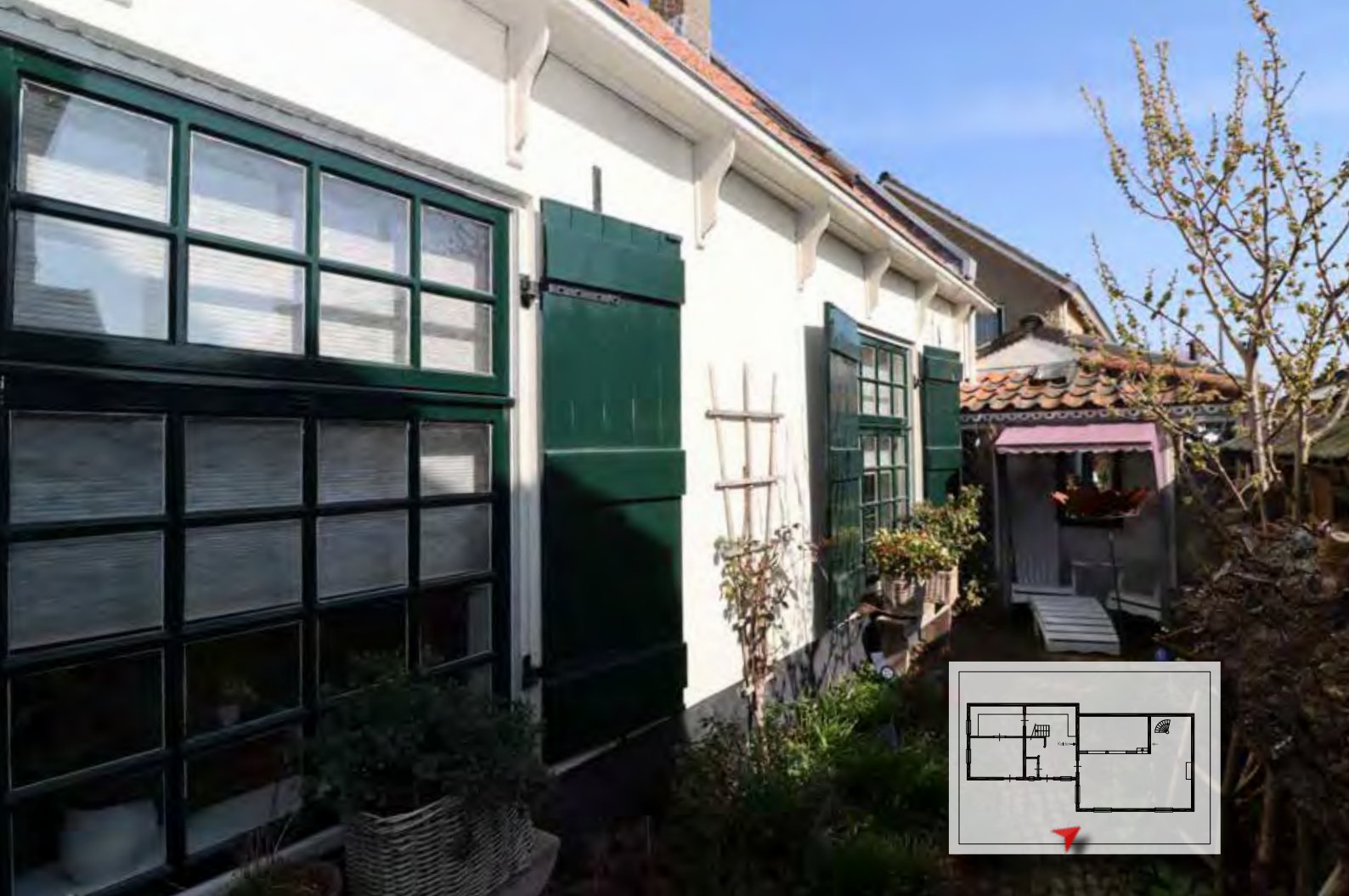
AFBEELDING (boven): De zuidoostgevel van het achterliggende deel
