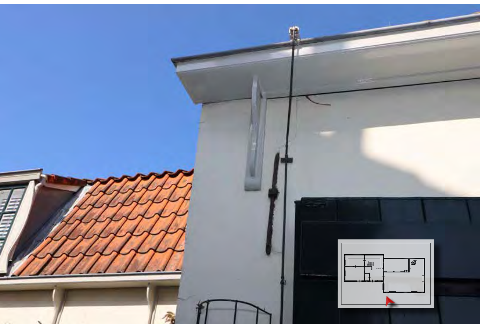
AFBEELDING (onder): De houten bakgoot met gootdragers en een gesmeed gevelanker
